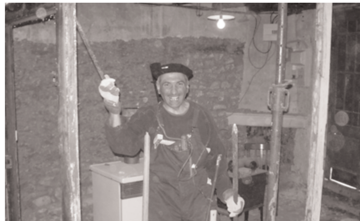
Sylvain Roux pendant les travaux de L'insoliste. Photo Étienne Roux
